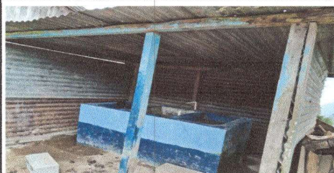
Foto 2: Sustrucion de estructura de soporte de madera por metal
