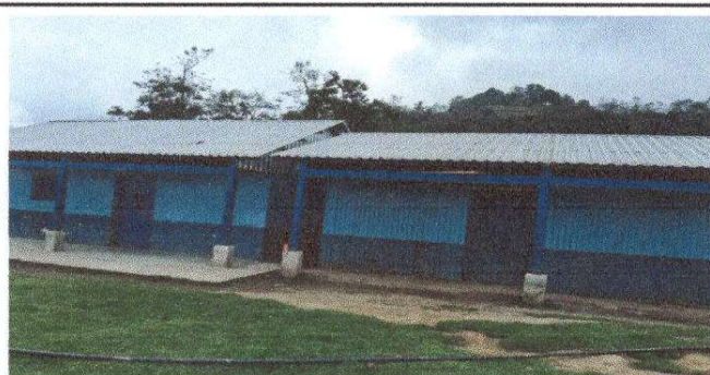
Foto 5: Sustrucion de piso de torta de concreto
