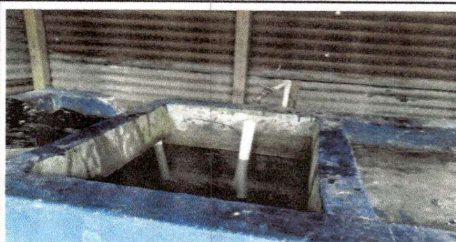
Foto 8: Sustrución de pila grande de dos lavaderos
