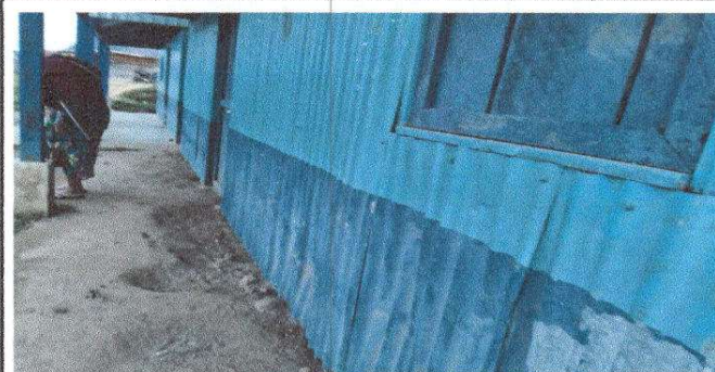
Foto 4: Sustrucion de ventanas de madera por metal, mas vidrio
